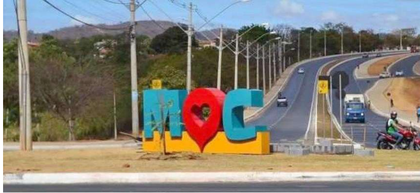
Figura 6: Obra conduzida pela Prefeitura de Montes Claros
